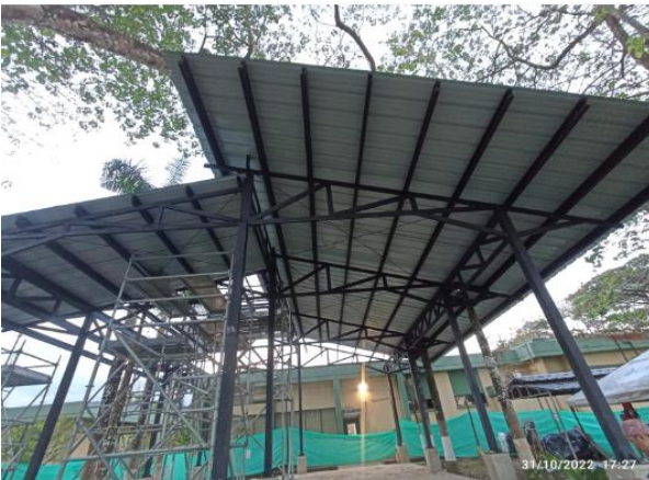
Construcción estructura comedor Alterno CPF Cup.
