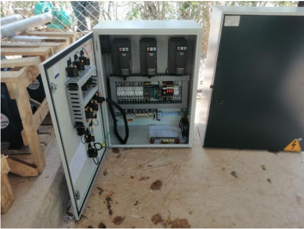
Suministro e Instalación Tablero de control y tablero de potencia para sistema de bombas 1 y 2 CPF Cup.
