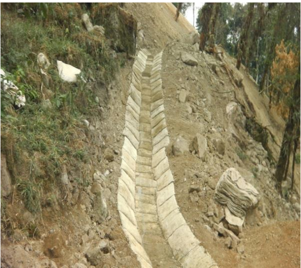
Construcción corta corriente en saco suelos vía a pozo Cup. T33
