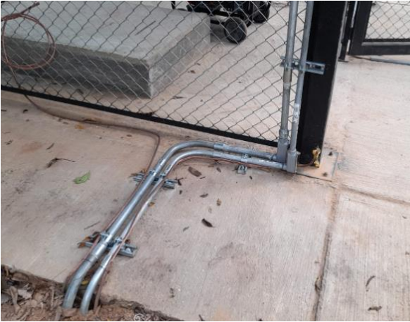
Instalación de tubería IMC, barraje equipotencial y accesorios eléctricos Casetas Bombas 1 y 2 Cpf Cup.
