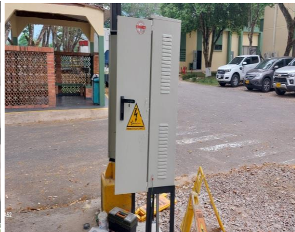
Suministro e Instalación de soporte y gabinete para cargador.
