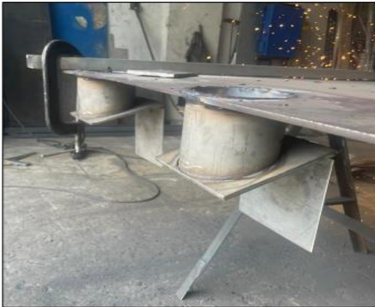
Instalación de válvulas chapaletas en acero inox. 304 en cámaras internas del floculador PTAP CPF Cup.
