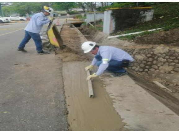
Construcción Cuneta Zona Casino CPF Cup
