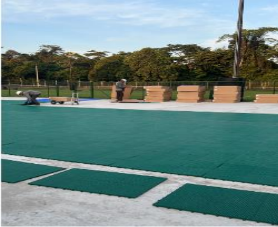
Instalación Piso modular duracourt Canchas CPF Cup.
