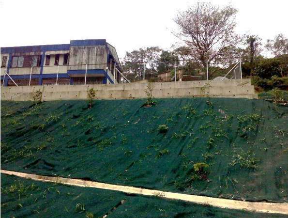
Reconstrucción área pendiente de colegio Aguazul.
