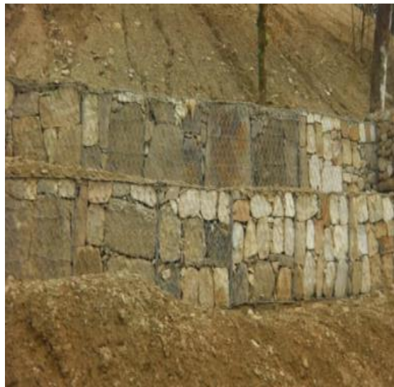
Construcción gaviones vía a pozo Cup. E
