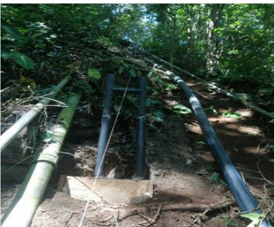
Construcción línea de impulsión Bocatoma CPF Cup.
