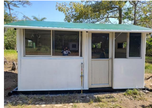
Construcción Caseta de Vigilancia Patio de tubería Cup.
