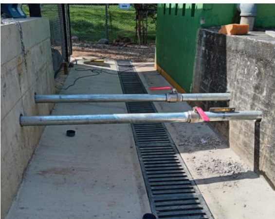
Instalación de vasos comunicantes en tubería galvanizada y válvulas de 3"
