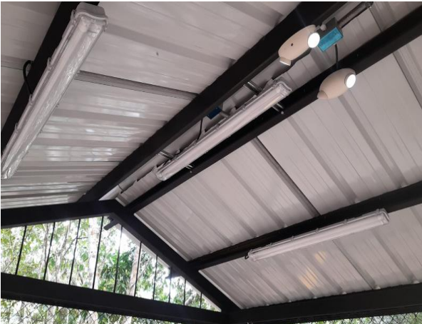
Construcción estructura Casetas de bombas 1 y 2 CPF Cup.
