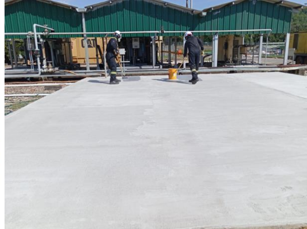
Aplicación de recubrimiento epóxico de placa PTAP.
