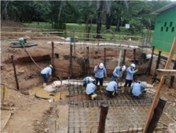
Cimentación Caseta Bocatoma CPF Cup
