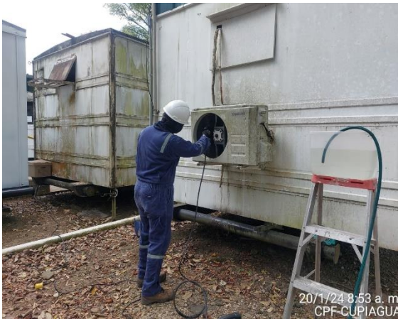
Mantenimiento a aires acondicionados CPF Cup.
