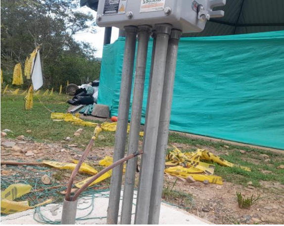
Suministro e instalación sistema eléctrico banco ductos
