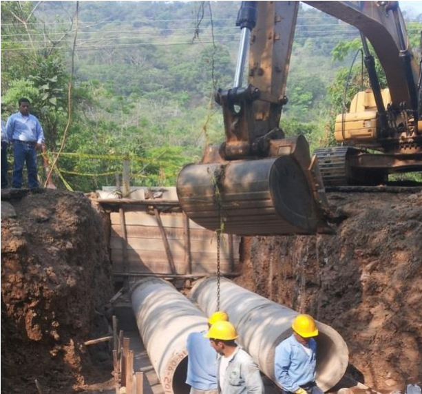
Mantenimiento vía pozos Cup. XB
