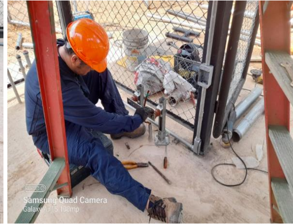
Instalación de tubería IMC, barraje equipotencial y accesorios eléctricos Casetas Bombas 1 y 2 Cpf Cup.
