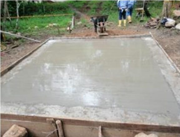
Cimentación Caseta Bocatoma CPF Cup
