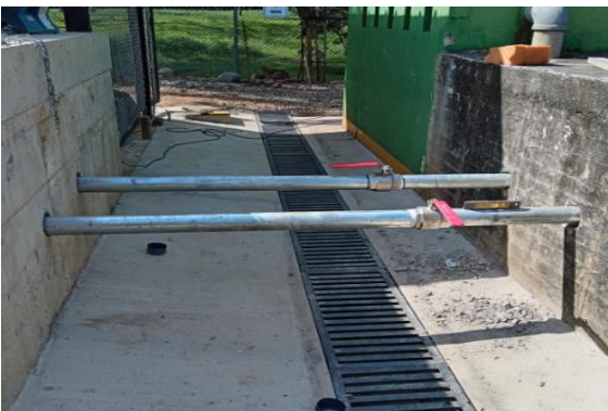
Construcción tanque almacenamiento Bocatoma CPF Cup.
