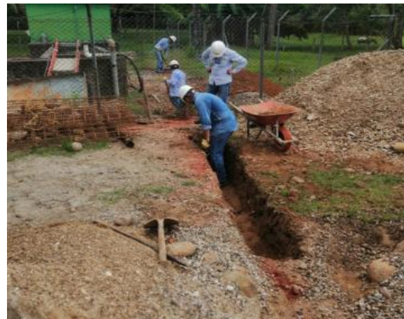
construcción de banco ducto BocATOMA CPF Cup.
