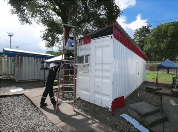
Adecuación estructura cubierta de contenedor.
