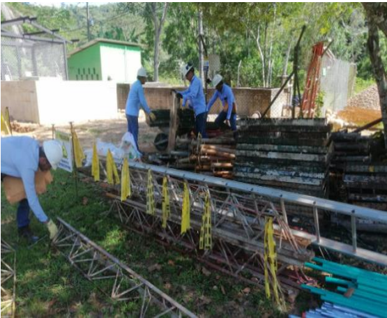
Construcción tanque de almacenamiento Bocatoma CPF Cup.
