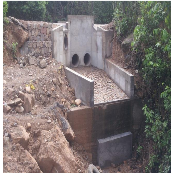
Construcción alcantarillas vía pozos Cup. XB y XH.
